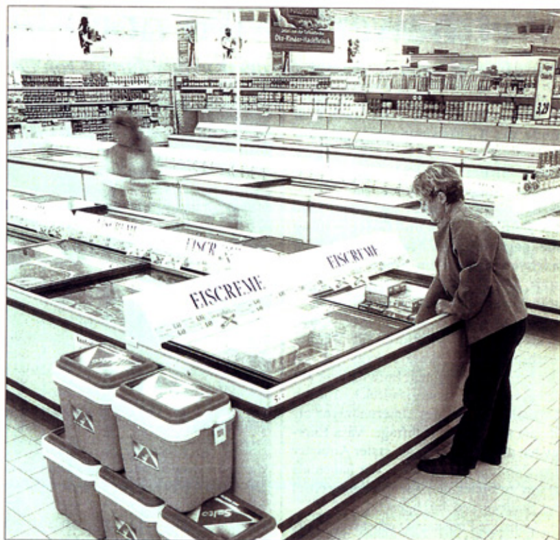
Einsparpotentiale: Auch bei Kühltheken lohnt es sich, den Energieverbrauch zu analysieren und zu steuern.
